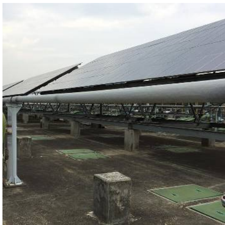
②最初沈澱池
